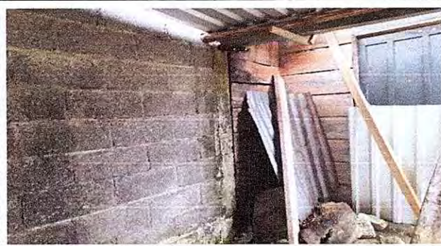
Foto 3: Segulimiento de construcción de cocina de block.
