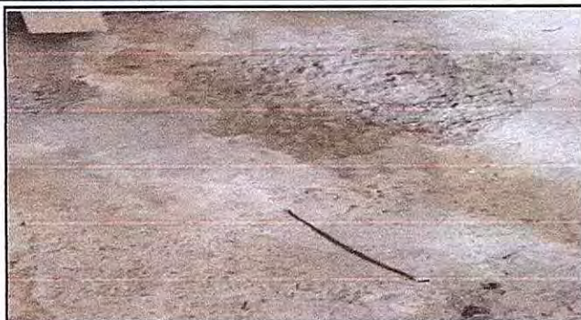
Foto 7: Cambio de piso de cemento por piso antideslizante en 5 mts X 8 Mts corredos.
