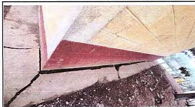
Foto 9: Repello detrás 4 aulas, 50cm de altura.
